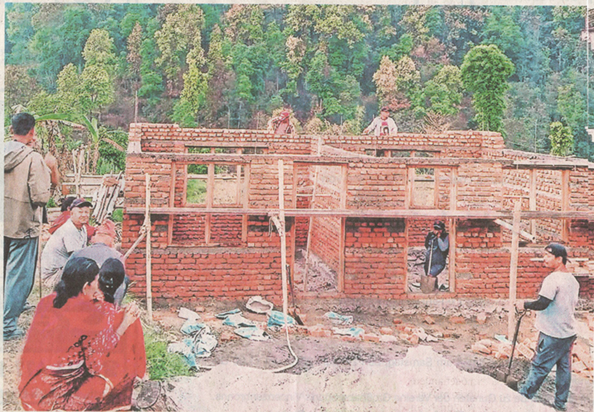
Stein für Stein wurden die Häuser der Nepalhilfe Cadolzburg für die vier Familien gemauert, die dafür auch einen Eigenbeitrag leisten mussten.
